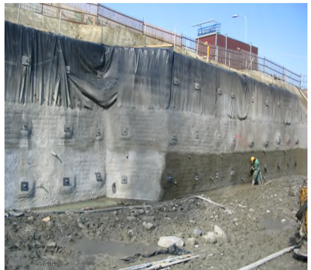
Face Est en bordure de route
