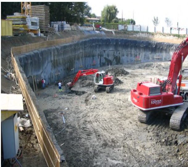
Vue générale face Nord
