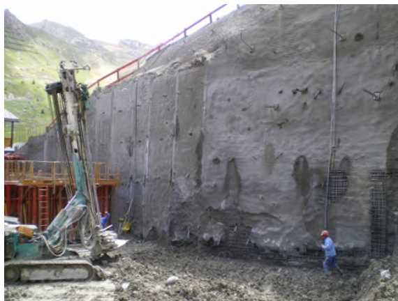
Vue de détail de la paroi microberlinoise
