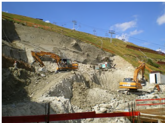
Début des travaux à l'aval du télésiège
