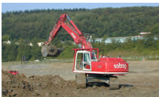
Tri en continu lors du terrassement
