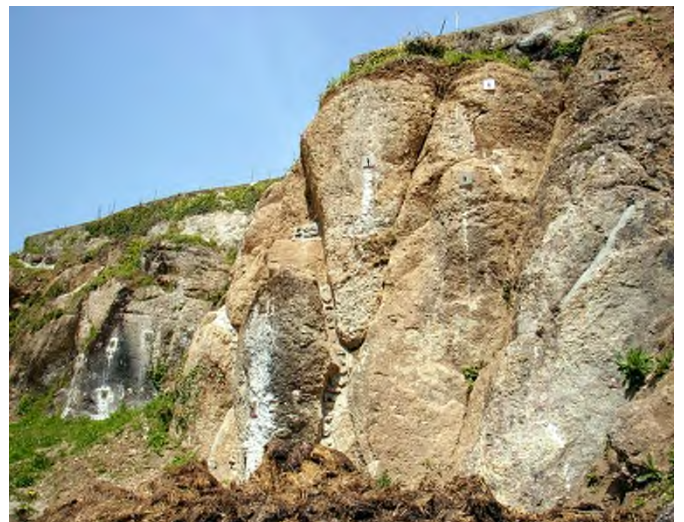
Mesures de confortation
